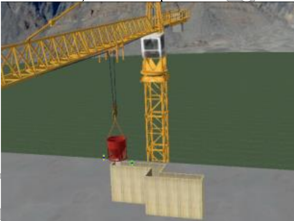
Turnare beton în cofraj
