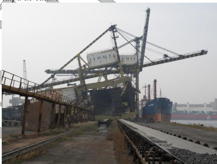
Accident datorat unui vânt puternic de peste 150km/h datorită neasigurării pe calea de rulare a două poduri rulante
