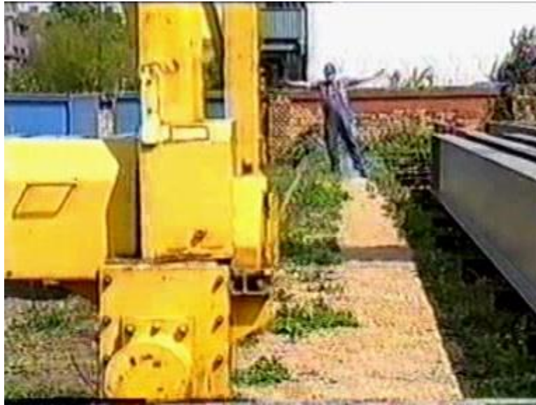
Deplasarea macaralei spre sarcina de ridicat la indicațiile legătorului de sarcini
