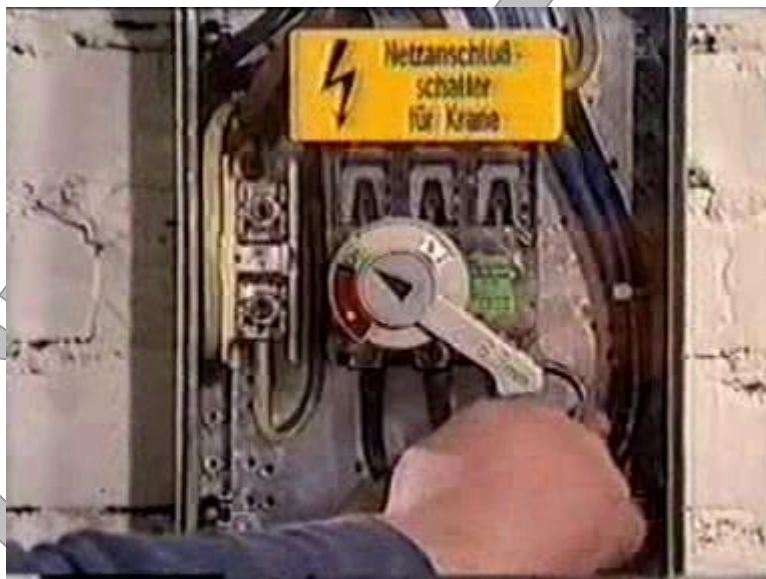
Cuplarea întrerupătorului general după scoaterea lacătului.
