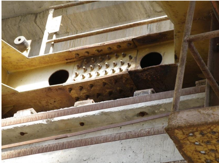
Ruginirea structurii metalice pod rulant
