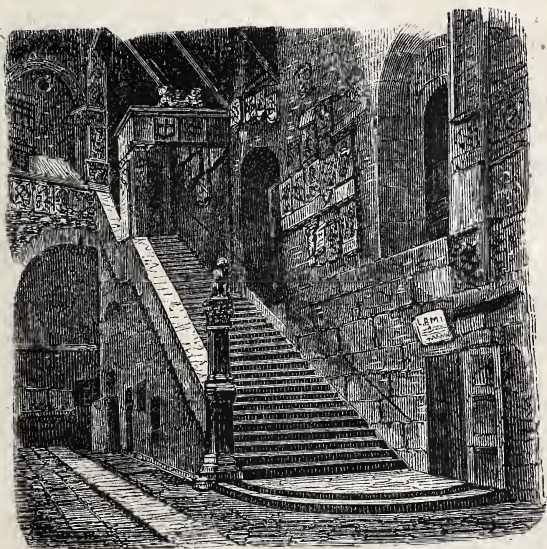
Cortile e scala interna del Bargello.
